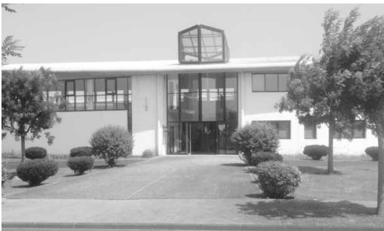
Bâtiment d'accueil site de St Beauzire
